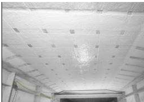
補修: 炭素繊維シート貼付
