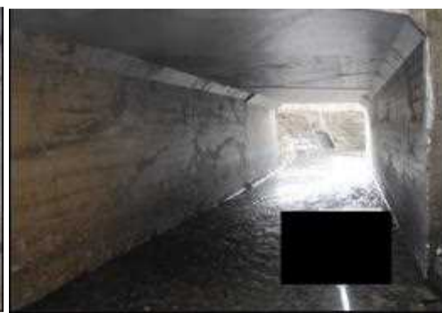
補修: 断面補修
